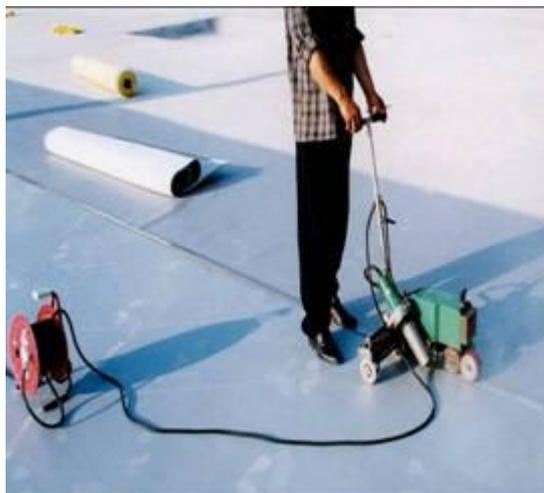
7. 节点处理：裁剪适合相应节点的卷材片材，采用手持式焊枪将片材焊接于大面卷材上。
