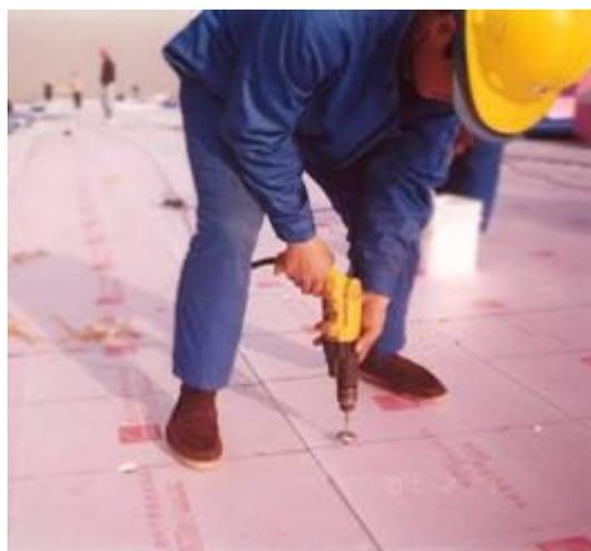
4. 预铺 TPO 防水卷材: 将 TPO 防水卷材按弹线控制位置布置在保温层上, 卷材铺设方向与压型钢板波纹方向垂直, 把自然疏松的卷材按轮廓布置在保温层上。卷材保持平整顺直, 不得扭曲, 搭接宽度 120mm, 并进行适当的剪裁。
