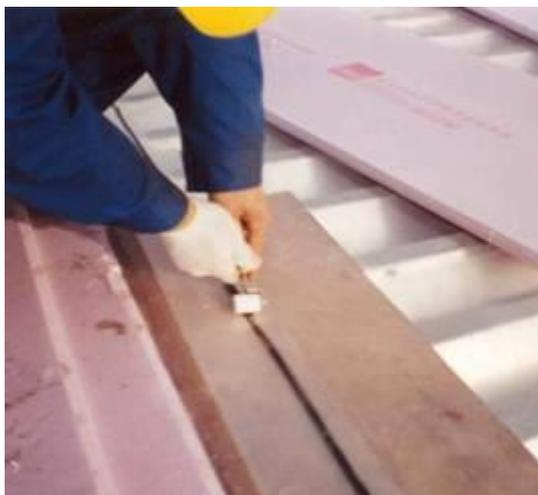
3. 铺设挤塑聚苯乙烯泡沫保温板（XPS），采用专用紧固件固定保温板。
